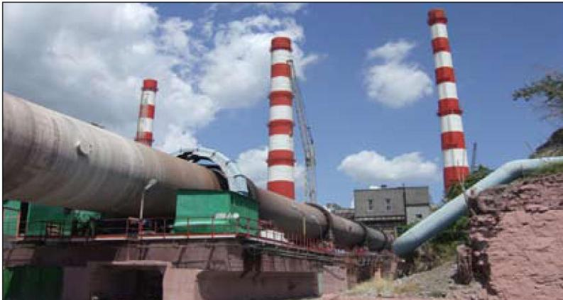
сотник» при реконструкции дымовых труб одного из крупнейших производителей цемента ОАО «Новороссцемент». Цель использования заключалась в защите железобетонных труб от разрушающего воздействия конденсата, образовывающегося на внутренней поверхности вследствие резкого перепада температур.
